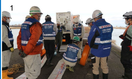
① 排水ポンプ車からロープやポンプを降ろして準備 ② 増水した災害現場を想定した庄内川に2組の排水ポンプとホースを設置
