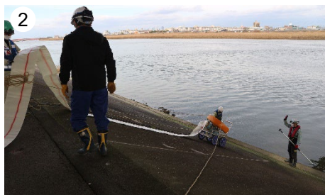
① 排水ポンプ車からロープやポンプを降ろして準備 ② 増水した災害現場を想定した庄内川に2組の排水ポンプとホースを設置
