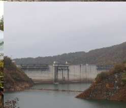
普段は通れない 工事用通路からの眺め
