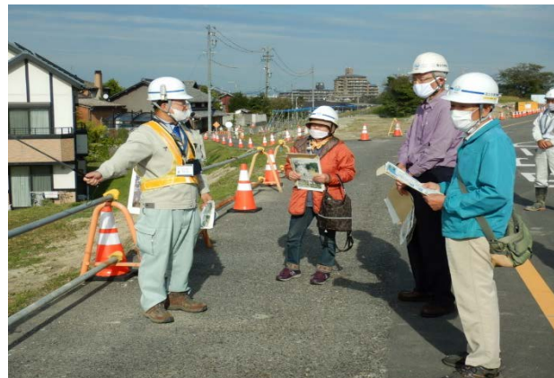
大野木築堤工事の現場見学の様子
