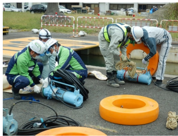
操作説明を受け、排水ポンプとホースの接続を実施
