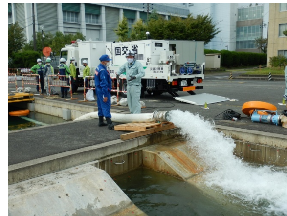
排水ポンプ車の設置を完了し、排水作業を開始
