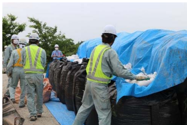
ブルーシートの押さえと端部の調整として小口土のう72個を設置
