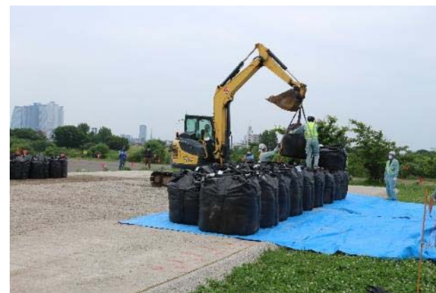
建設機械を使用し大型土のう25個を前後2列に積みさらに河川側は2段に積み上げます
