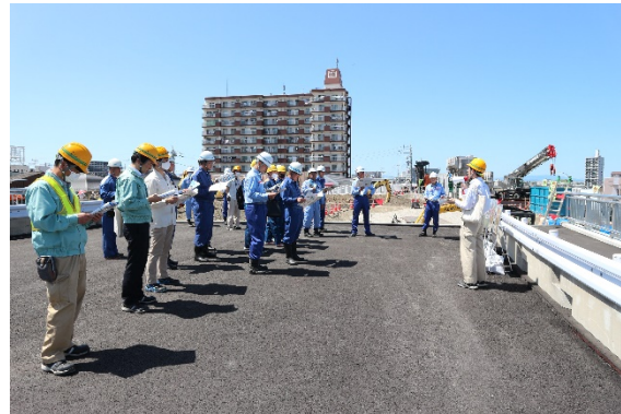
枇杷島橋迂回路仮橋の現場を巡視
