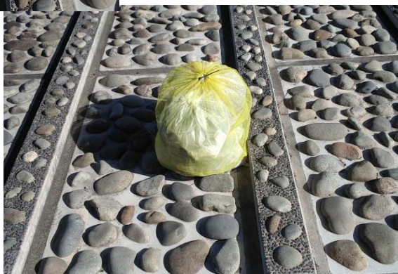
① 右岸 正徳橋橋梁下 川表小段
