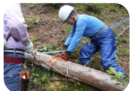
鉄塔コースの倒木処理
