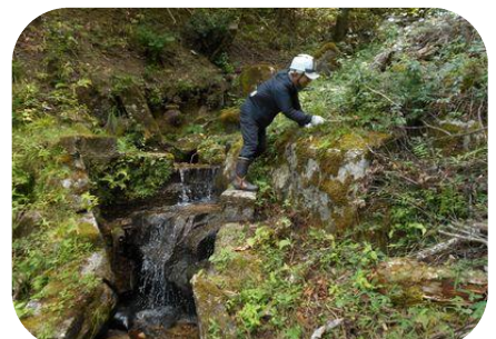
原石山中電遺構除伐
