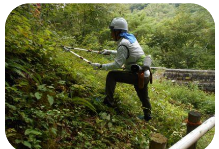
原石山中電遺構除伐
