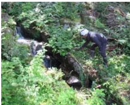
中電遺構溪谷作業中
