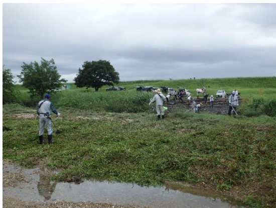
作業状況（全景）
