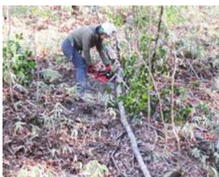
原石山中電遺構そばの溪谷整備①
