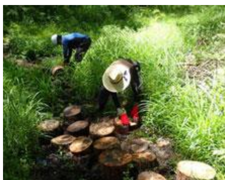
渡り道を輪切りで整備
