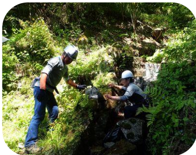
中電遺構の水路の補修
