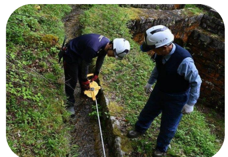
中電遺構の水路点検
