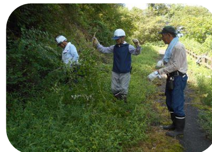
原石山除伐木処理作業
