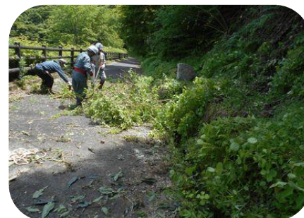
原石山除伐木処理作業
