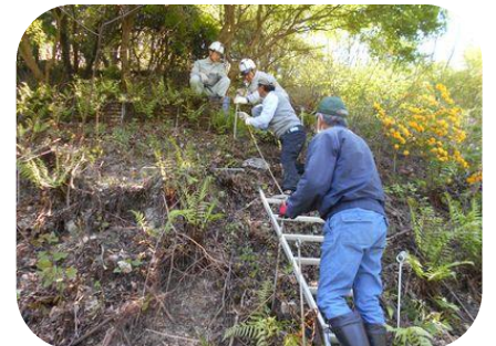
原石山登り口設置作業
