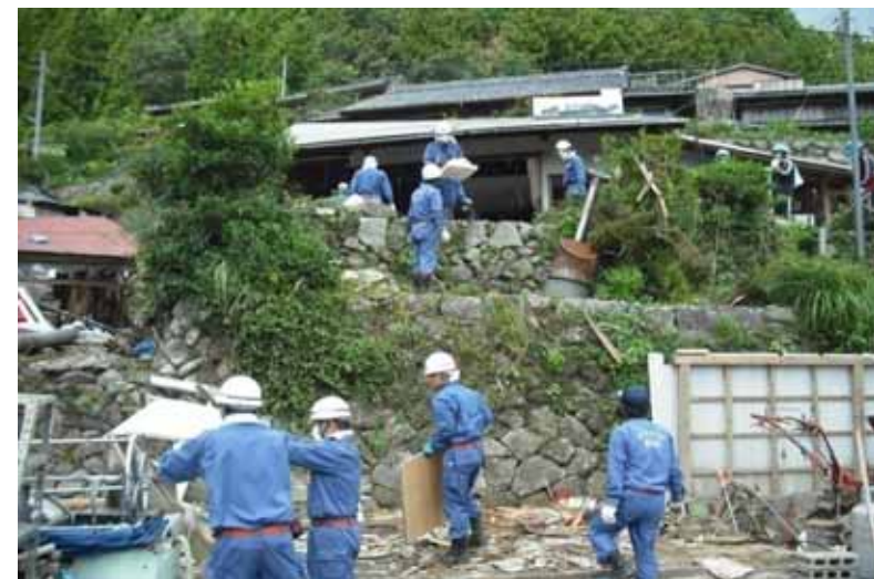
災害ゴミ撤去作業
