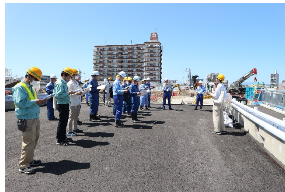
枇杷島橋迂回路仮橋の現場を巡視
