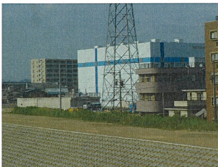
地蔵川排水機場
