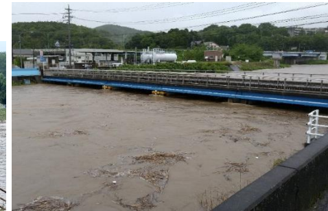
・周囲への越水を防ぐ陸閘の設置箇所付近
