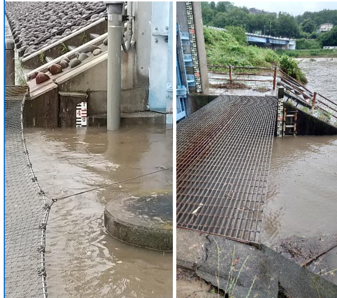
・支流への逆流を防ぐ樋門の設置箇所付近
