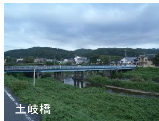
一級河川での河川橋梁改築
