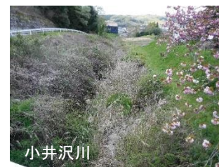
普通河川の河道掘削の実施
