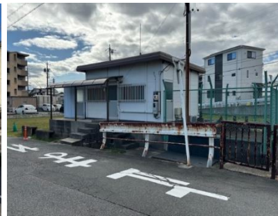
下河原ポンプ場付近
