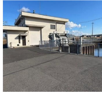
春日第二排水機場
