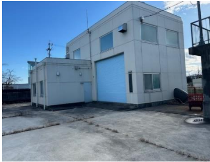
春日排水機場
