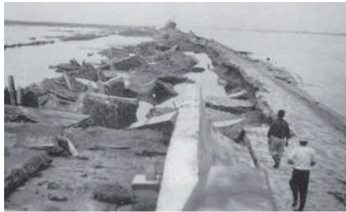
半田武豊海岸堤防の被害の様子 出典：内閣府 災害教訓の継承に関する専門調査会 <広報「ぼうさい」>第20回
