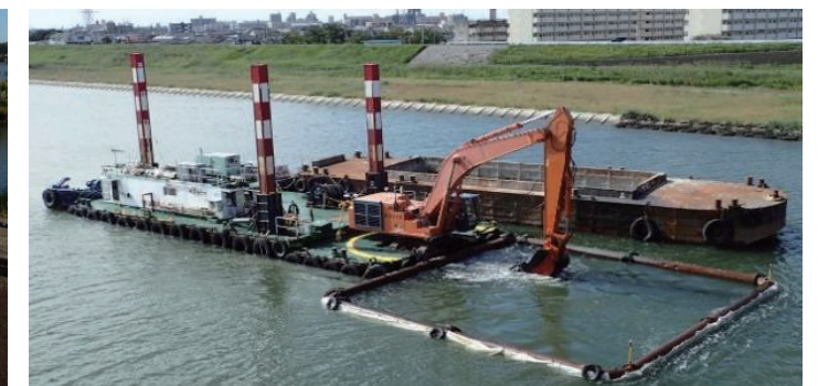
川の中の土砂をとる工事
