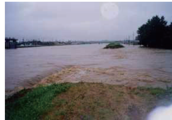
平成12年東海豪雨での新川決壊の様子
