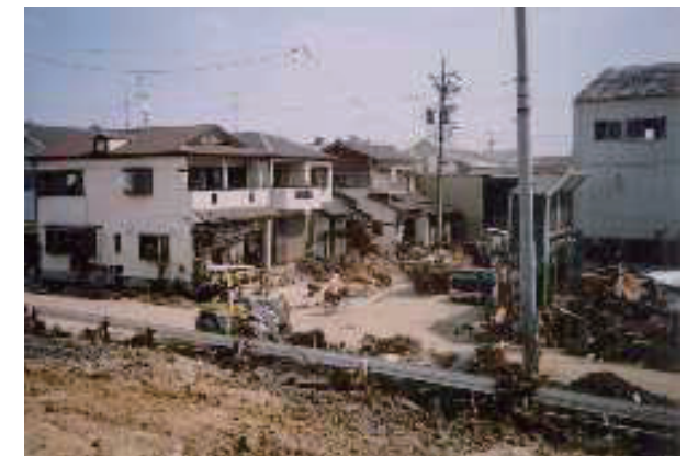
新川の決壊によりこわれた家 出典：新川破堤の復旧作業/愛知県河川課
