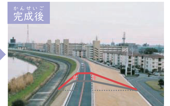
堤防の工事 (堤防の高さや幅が不足していた箇所を整備)
