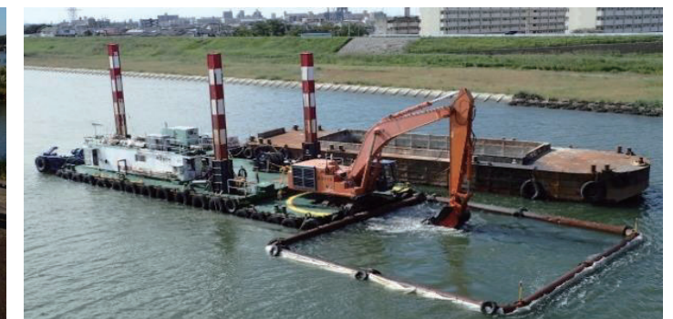
川の中の土砂をとる工事
