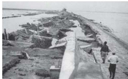
半田武豊海岸堤防の被害の様子 出典：内閣府 災害教訓の継承に関する専門調査会 <広報「ぼうさい」>第20回 (https://www.bousai.go.jp/kyoiku/kyokun/kyoukunnokeshou/pdf/bs0809.pdf)
