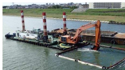
川の中の土砂をとる工事
