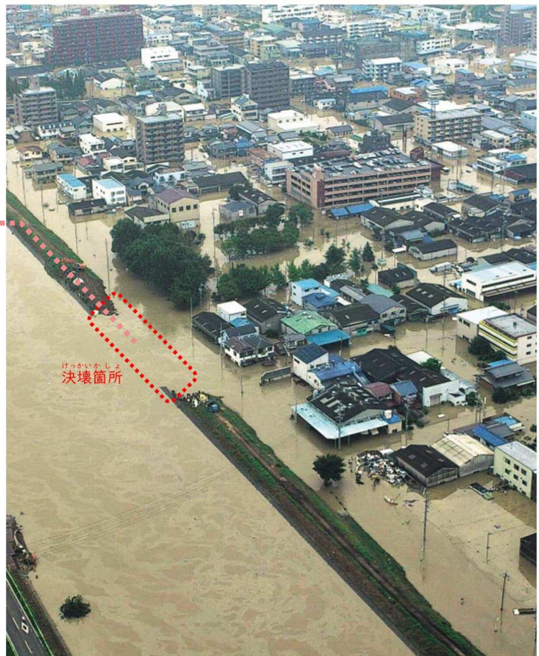
新川の決壊箇所と周辺の浸水の様子
