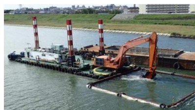
川の中の土砂をとる工事
