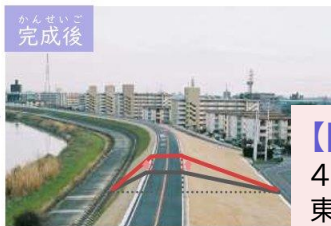
堤防の工事 (堤防の高さや幅が不足していた箇所を整備)
