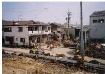
新川の決壊によりこわれた家 出典：新川破壊の復旧作業/愛知県河川課
