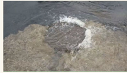
この影響で、排水できなくなった雨水がマンホールから溢れて、
