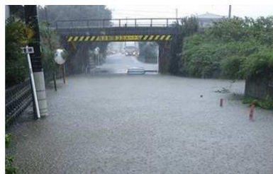
低い道路が浸水し、車が水没した様子 出典：国土交通省関東地方整備局千葉国道事務所 X (旧 twitter)
