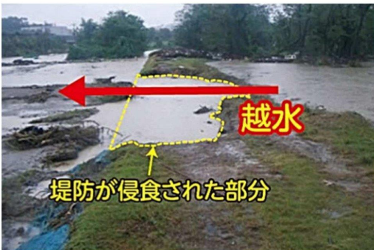
越水によって堤防が侵食された様子
