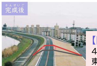
堤防の工事 (堤防の高さや幅が不足していた箇所を整備)
