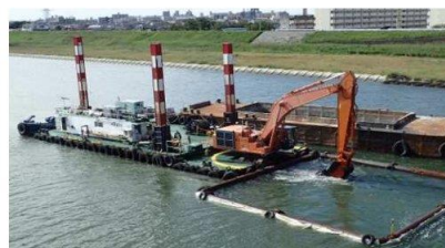
川の中の土砂をとる工事
