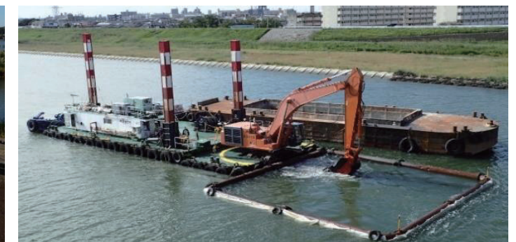
川の中の土砂をとる工事
