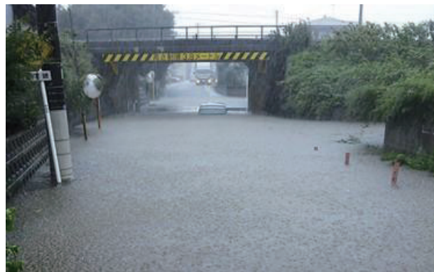
低い道路が浸水し、車が水没した様子
