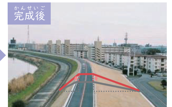
堤防の工事（堤防の高さや幅が不足していた箇所を整備）
