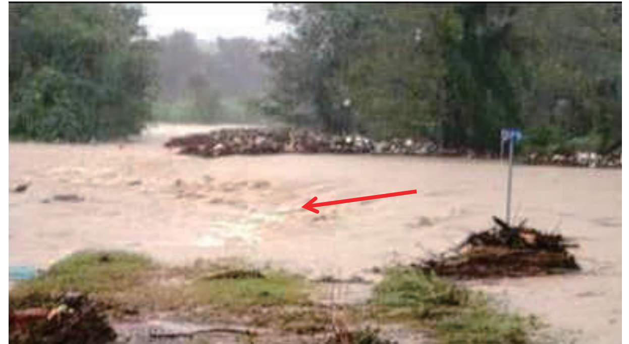
しだみきく とうすい 志段味地区での越水の様子
