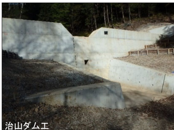
治山施設の整備(愛知県)
