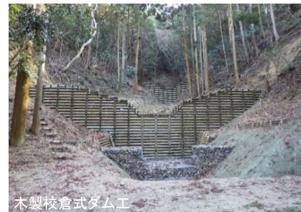
治山施設の整備(愛知県)
