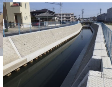
堤防整備(一宮市(準)千間堀川)
