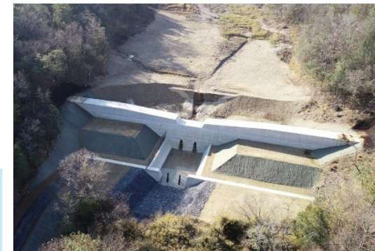
＜岩山第4砂防堰堤＞ 砂防施設の整備(多治見砂防国道事務所)
