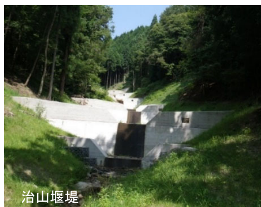
治山施設の整備(岐阜県)
