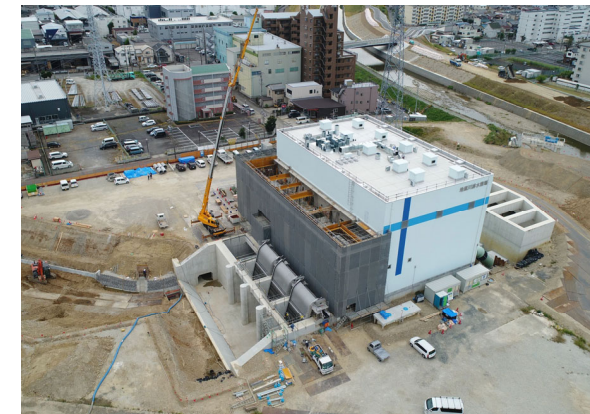
地蔵川排水機場の整備(愛知県)
