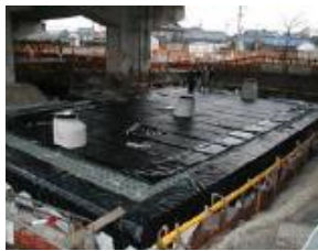
雨水貯留施設の整備 （大治町）
