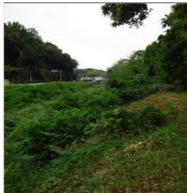
河畔林の繁茂状況
