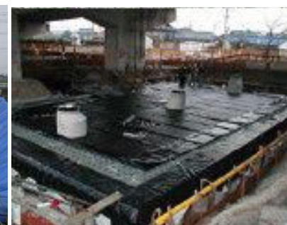
雨水貯留施設の整備 (大治町)
