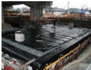
雨水貯留施設の整備 (大治町)
