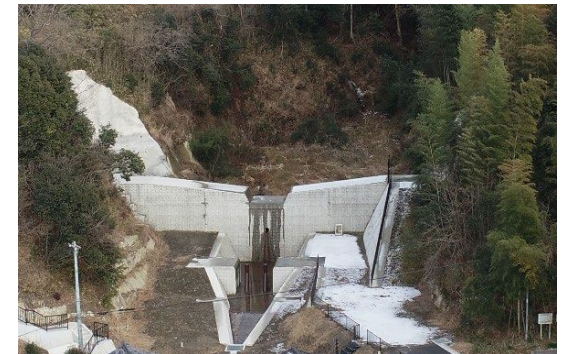
一の洞第2砂防堰堤 (多治見市)
