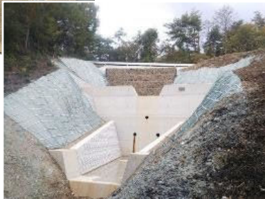
治山施設の整備 (岐阜県)
