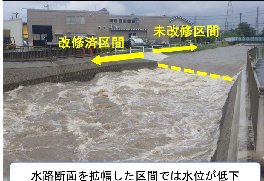
水路断面を拡幅した区間では水位が低下
