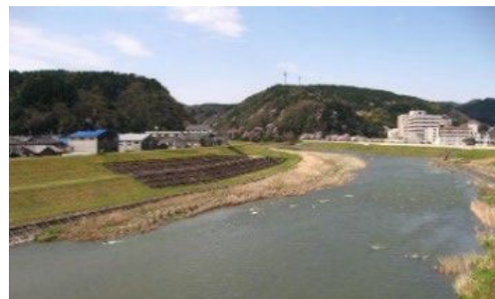
レキ河原再生【国長橋下流】 (庄内川河川事務所)
