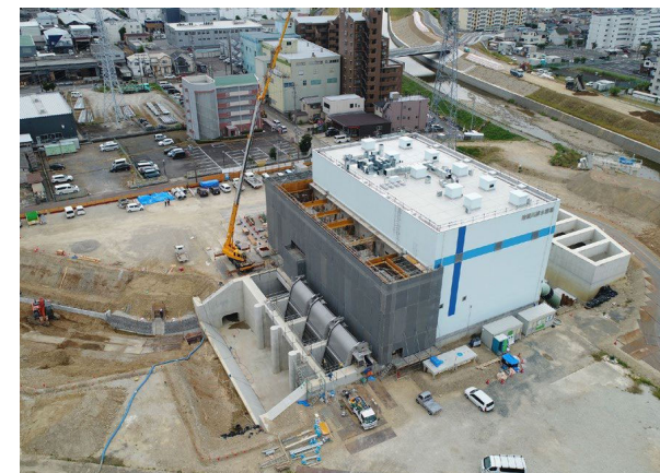
地蔵川排水機場の整備(愛知県)
