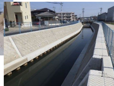
堤防整備(一宮市(準)千間堀川)
