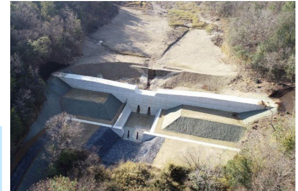
＜岩山第4砂防堰堤＞ 砂防施設の整備(多治見砂防国道事務所)
