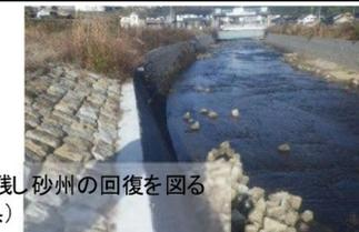
巨礫を河岸に残し砂洲の回復を図る
