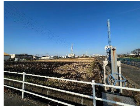
畔の嵩上げ・排水路改修による 雨水流出抑制（小牧市）
