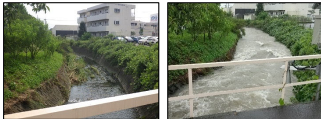
平常時 増水時 (R2.7.18 30mm/h) 一級河川天神川 【写真】天神川1号橋より下流側を撮影
