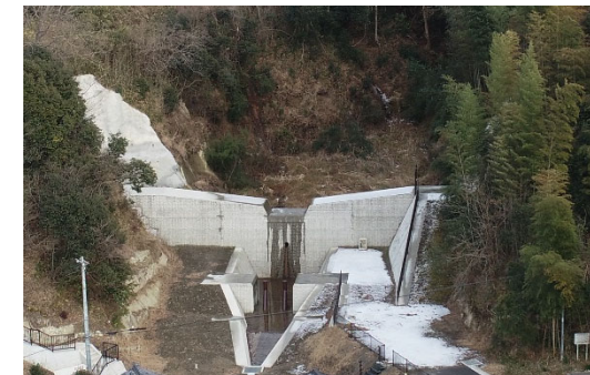
一の洞第二砂防堰堤 (多治見市)
