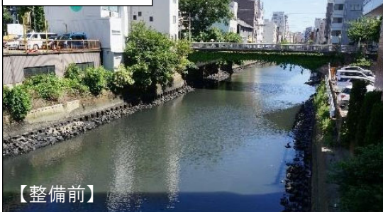
堤防(護岸)整備
