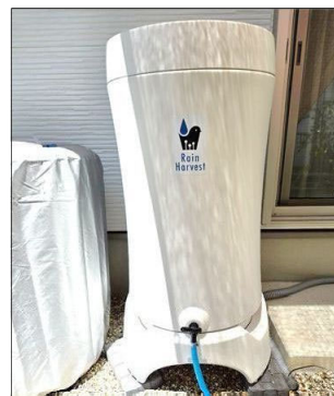
各家庭における雨水貯留施設 (雨水タンク)の設置状況
