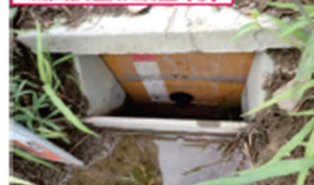
流出調整板設置の例
