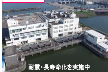
日光川排水機場
