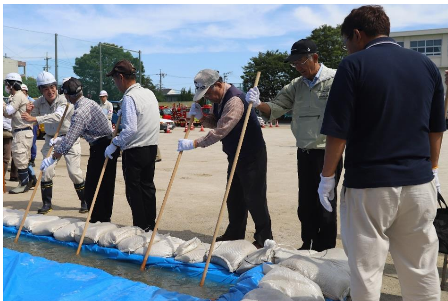
【水防訓練の参加住民が冠水道路体験を行っている様子】
