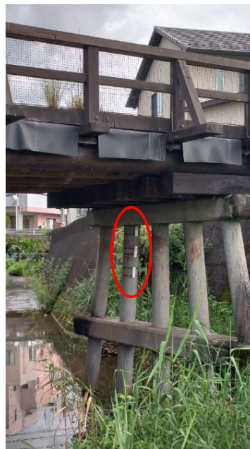
陸開付近の橋脚
