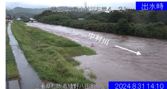
中村川（4.2k付近・島田橋）の出水状況 8/31_14:10
