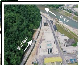
脇之島川の合流処理及び整備 事業期間:平成25～30年度 事業主体:国土交通省、多治見市
