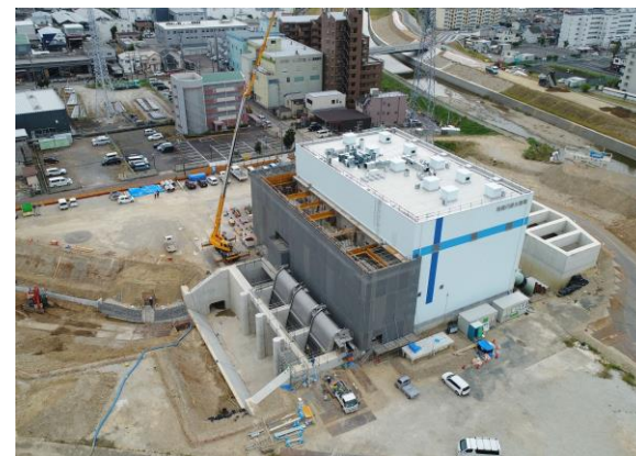
地蔵川排水機場の整備(愛知県)
