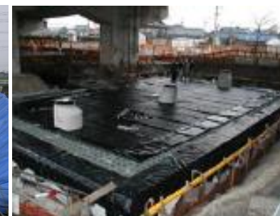
雨水貯留施設の整備 (大治町)
