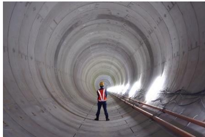
名古屋中央雨水調整池
