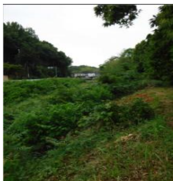
河畔林の繁茂状況
