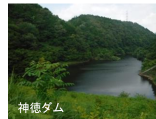
既設ダム2ダムにおける事前放流等の実施・体制構築
