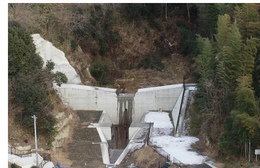
一の洞第二砂防堰堤 (多治見市)
