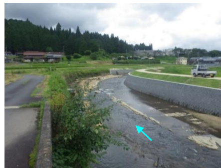
河川整備の状況（河道掘削・堤防整備）【小里川】
