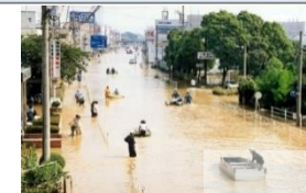
雨水ポンプ場の機能強化
