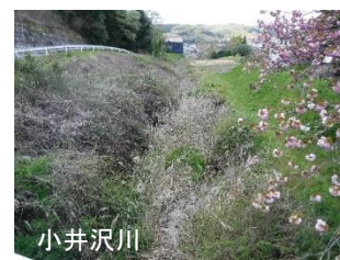
普通河川の河道掘削の実施
