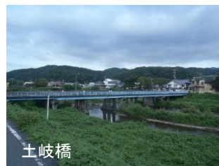
一級河川での河川橋梁改築
