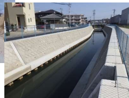
堤防整備(一宮市(準)千間堀川)
