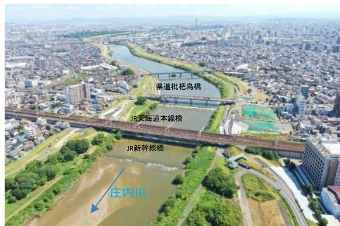
橋梁改築一狭窄部対策(庄内川河川事務所)
