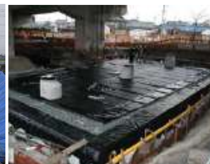
雨水貯留施設の整備 (大治町)
