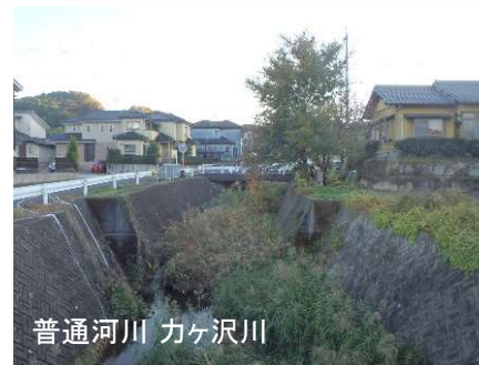
普通河川の河道掘削の実施
