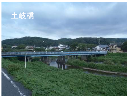
一級河川での河川橋梁改築
