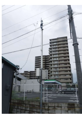
河川カメラの設置状況
