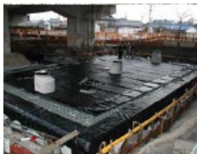
雨水貯留施設の整備 （大治町）
