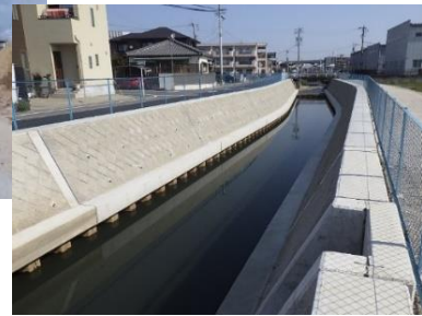
堤防整備(一宮市(準)千間堀川)
