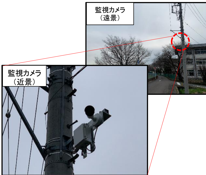
監視カメラの設置・増設(稲沢市)
