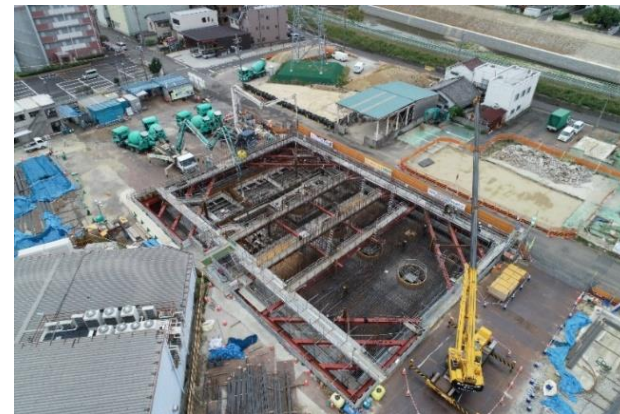
地蔵川排水機場の整備(愛知県)
