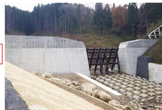
鍛冶ヶ入川第5砂防堰堤(土岐市)
