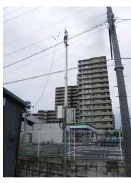
河川カメラの設置状況
